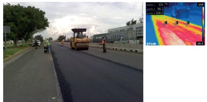
Figura 3. Temperatura mínima de compactación de 95°C de la mezcla asfáltica semicaliente para este tratamiento.
