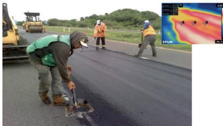
Figura 1. Aplicación del tratamiento superficial en la autopista Guadalajara-Colima, se observa que la mezcla asfáltica tibia se puede manipular por los trabajadores hasta temperaturas de 110°C.
